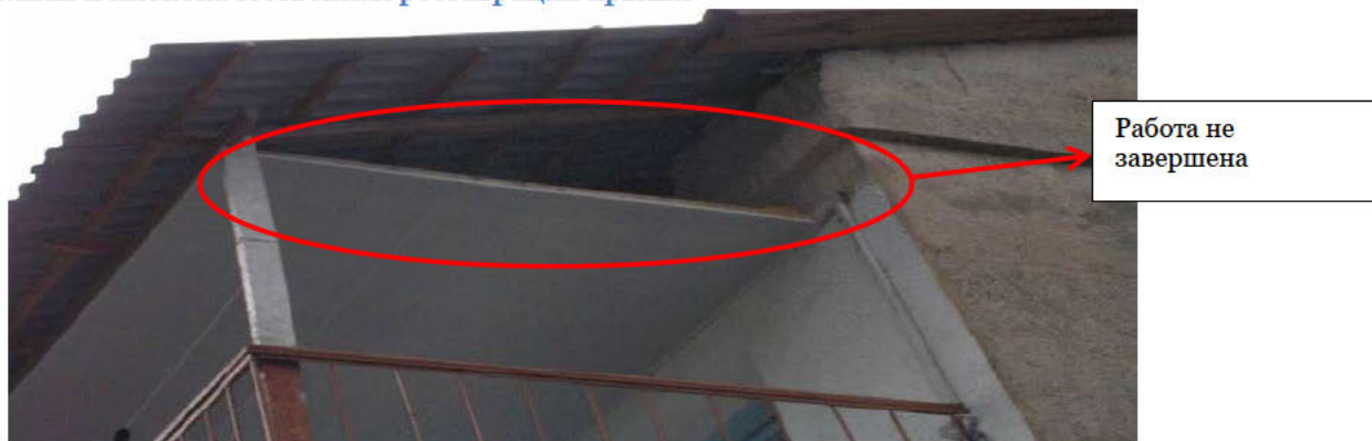
Рис. 30 - Низкокачественная реставрация крыши
