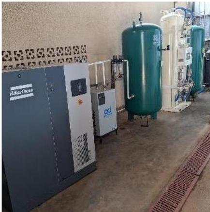
murales. Un compresseur d'oxygène supplémentaire est nécessaire pour augmenter la pression de l'oxygène dans la tuyauterie d'alimentation directe.
